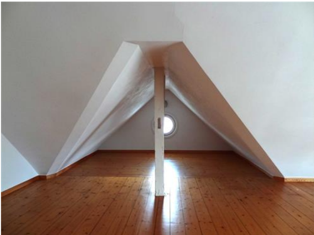
Raum unterm Dach Sicht 2
